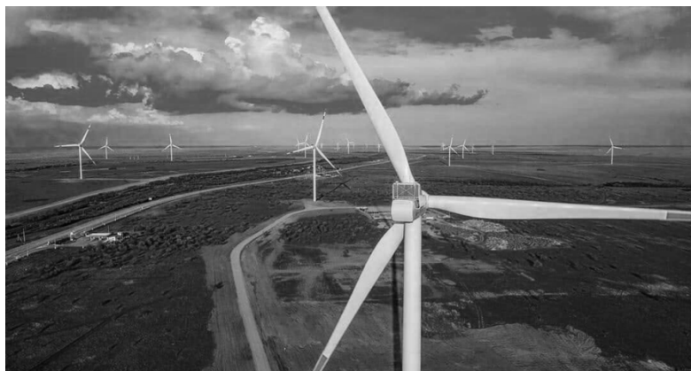
Рисунок 2. Каменская ВЭС, Ростовская область, 100 МВт, кластер из 26 установок по 3,85 МВт.
