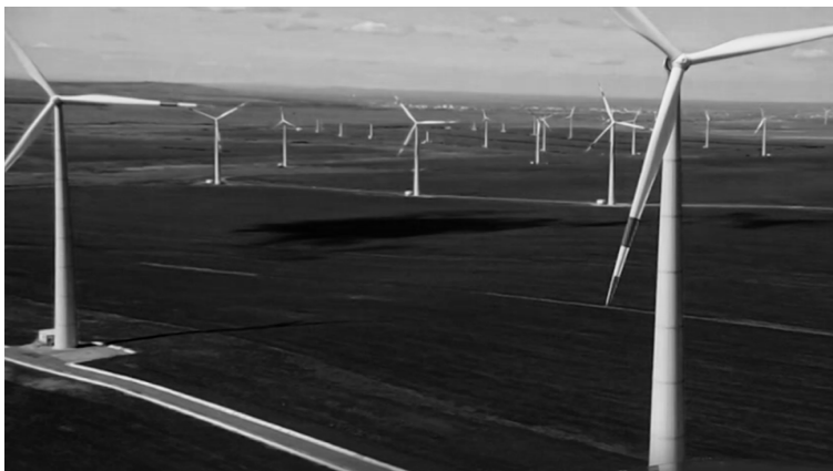
Рисунок 5. Линейная конфигурация электростанции с параллельными рядами агрегатов (Кузьминская ВЭС, Ставропольский край, 160 МВт, 64 установки по 2,5 МВт).
