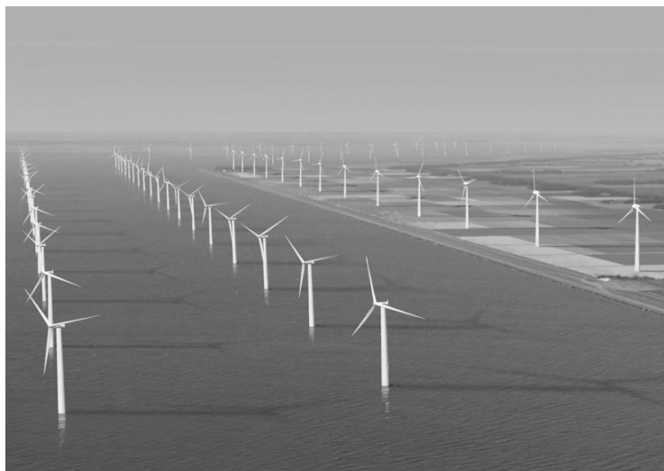
Рисунок 7. ВЭС Нюстед (Дания), 373 МВт, 162 установки по 2,3 МВт с параллельным рядным расположением.
