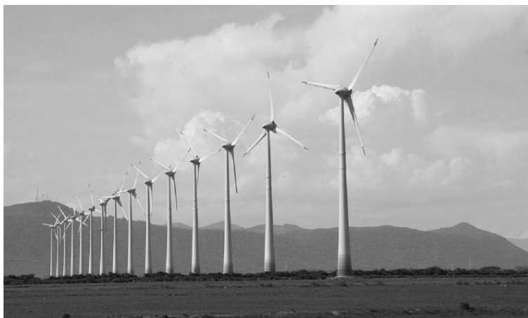
Рисунок 3. Однорядное расположение ветроустановок на ВЭС небольшой мощности.
